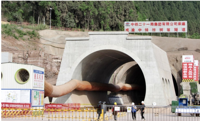
6月4日,成渝中线高铁棕树坡隧道贯通。中铁二十一局供图
