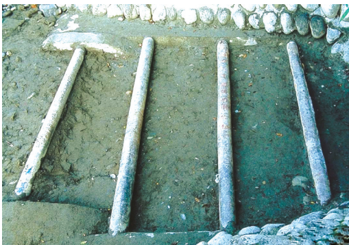
凤栖窝岸下河床底部埋设的卧铁。图据视界都江堰微信公众号
