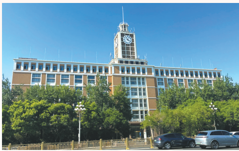
北京人记忆中的“电报大楼”1958年竣工,被誉为“新中国第一个大型综合通信枢纽”,如今已另作他用。 戴云 摄
