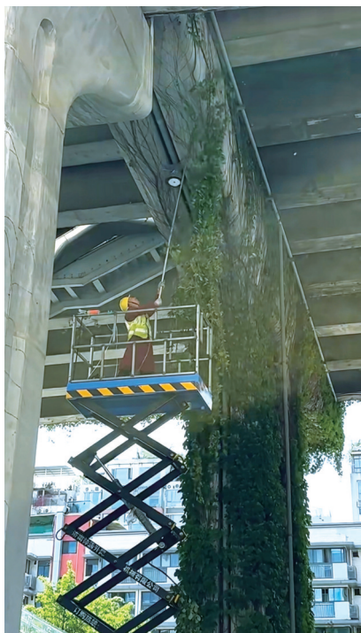
工人正在成都二环高架下使用长杆去除桥下的爬山虎枝叶。 视频截图
