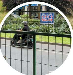
现场设置了围栏和警示牌。
