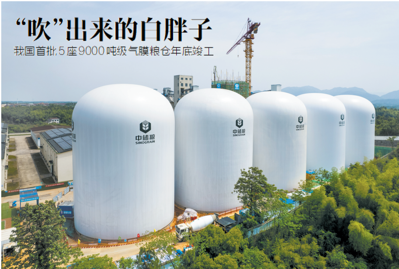
这是5月6日在中储粮长沙直属库拍摄的气膜粮仓建设施工现场(无人机照片)。新华社发
