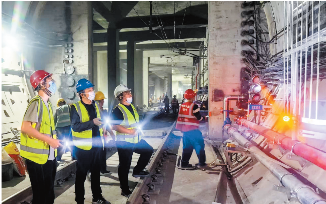
成都地铁13号线一期现场，200余名建设者节日期间坚守岗位。图据成都轨道交通
