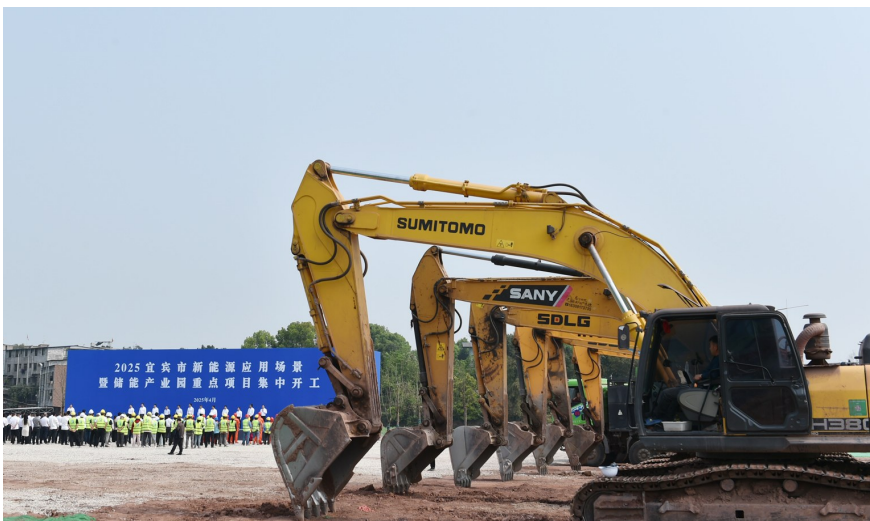
2025 宜宾市新能源应用场景暨储能产业园重点项目集中开工现场。
