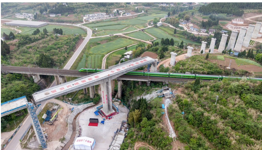
转体后,大桥横跨已通车的达成铁路。成达万高铁公司供图
