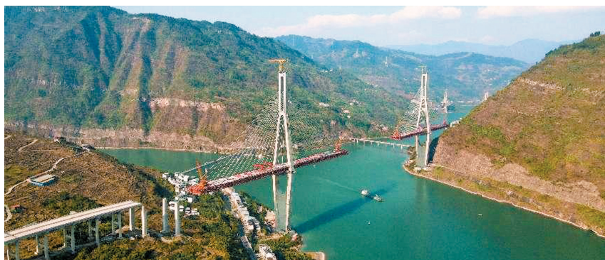
正在建设的新市金沙江特大桥。交通运输厅供图
