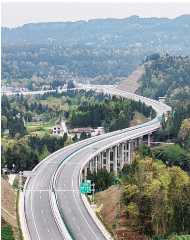
苍巴高速公路唱戏梁大桥。四川省交通运输厅供图
