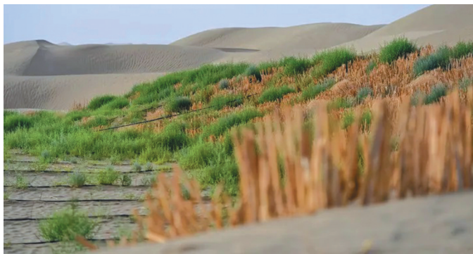
2024年6月15日，在新疆和田地区于田县阕东防沙治沙综合示范区，草方格沙障整齐排布“困住”流沙，红柳、梭梭等植被长势茂盛。
