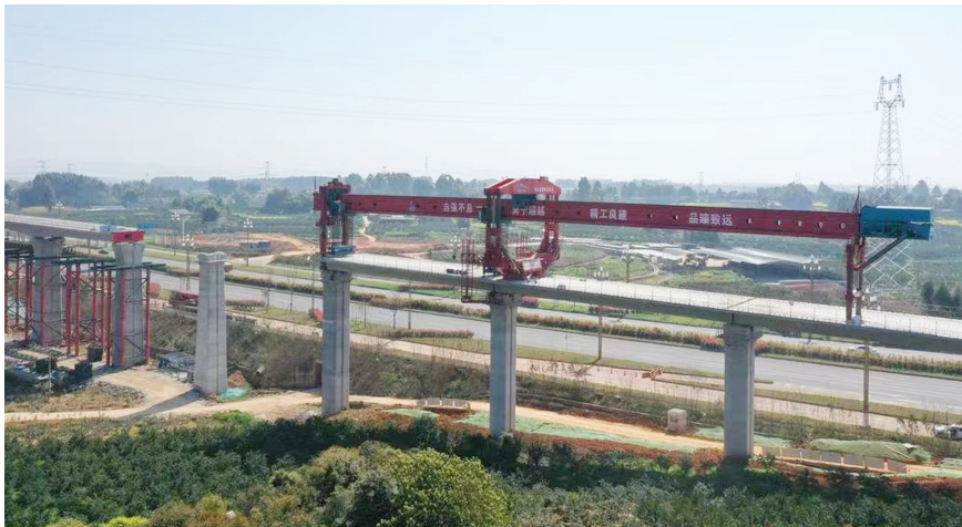
▲市域铁路成眉线箱梁架设现场。 成都轨道集团供图
