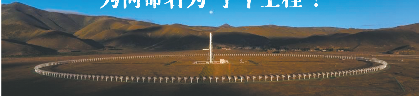
位于四川稻城的子午工程二期大型监测设备之圆环阵太阳射电成像望远镜(无人机照片)。
