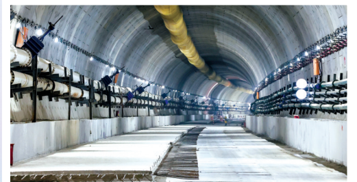
汕头湾海底隧道盾构贯通段。新华社发
