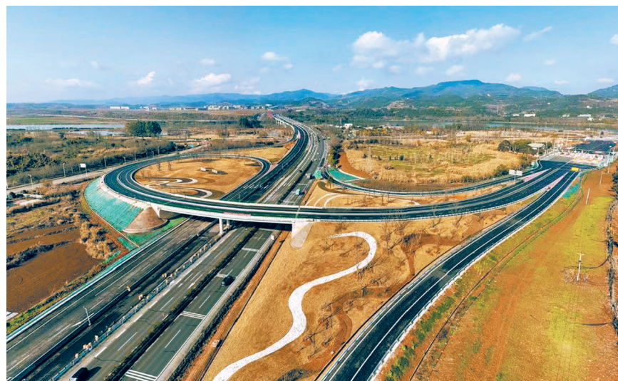
成南高速扩容工程准州新城段。交通运输厅供图
