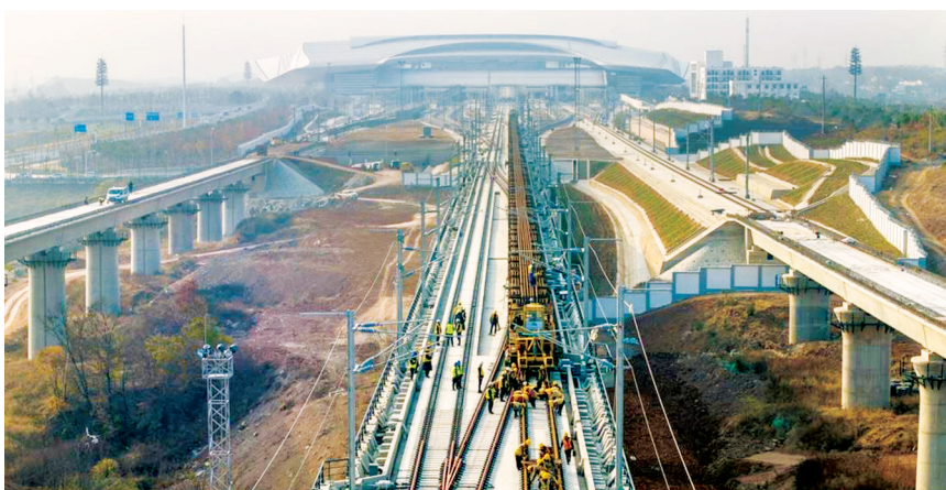
沪渝蓉沿江高铁武宜段铺轨现场。图据“中国铁路”微信公众号
