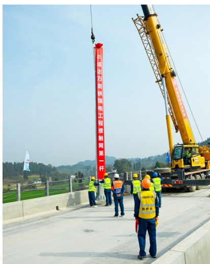
成达万高铁全线首根接触网支柱安装现场。
