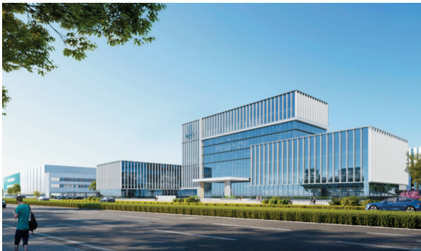
成发科能工业透平装备及燃机核心装备研发制造中心项目效果图。图据成发科能
