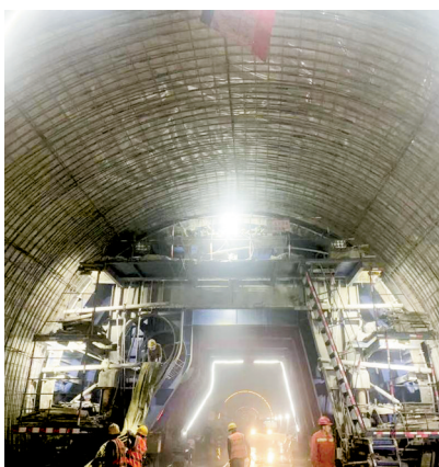
G664稻城县香格里拉至各卡段改建工程俄初山隧道施工现场。
