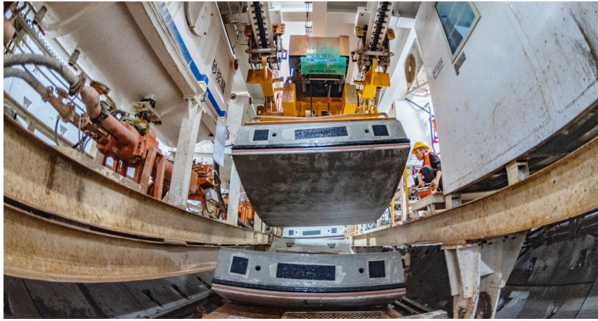
盾构管片拼装。成都轨道集团供图
