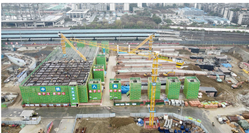
施工现场。受访者供图
