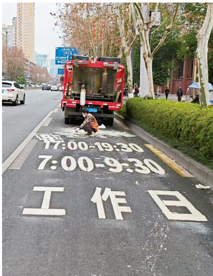
2月15日,成都市金牛区花牌坊街,工作人员正对公交车道交通标识、标线等进行更新。受访者供图
