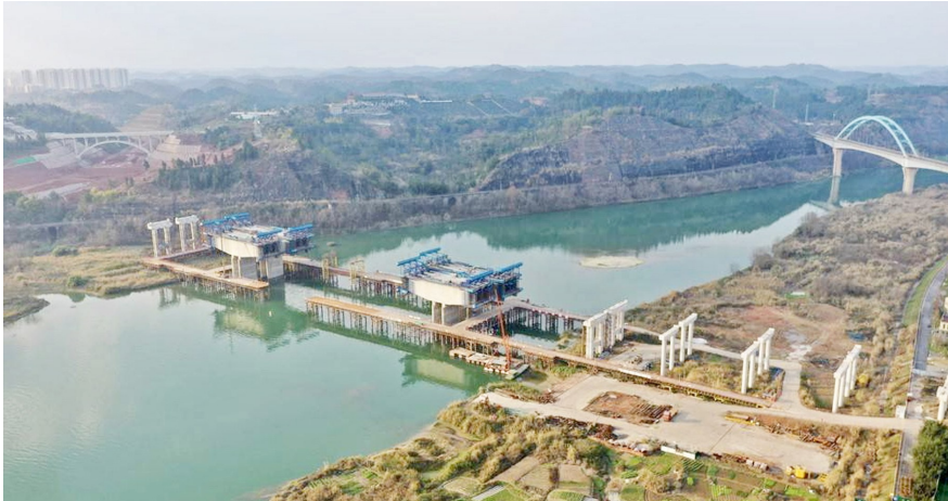
正在建设中的沱四桥。
