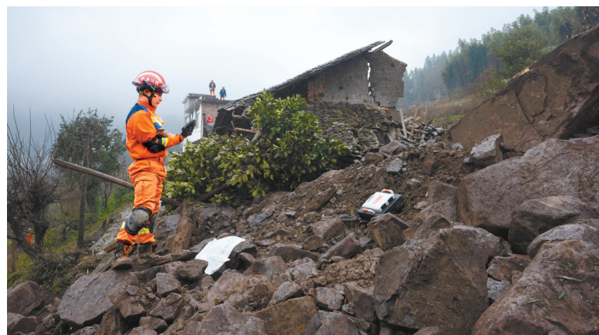
2月9日，消防员在用生命探测仪搜救被困人员。新华社发
