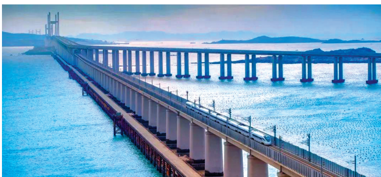
平潭海峡公铁大桥。图据平潭融媒体中心
