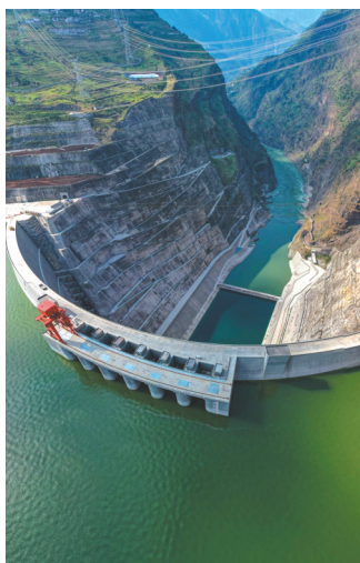
白鹤滩水电站大坝(无人机照片)。
