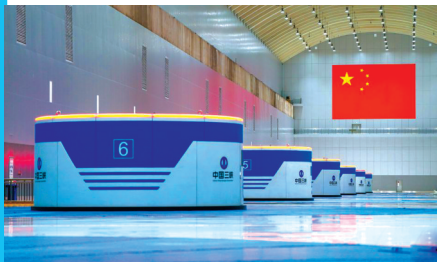
白鹤滩水电站左岸地下厂房。
