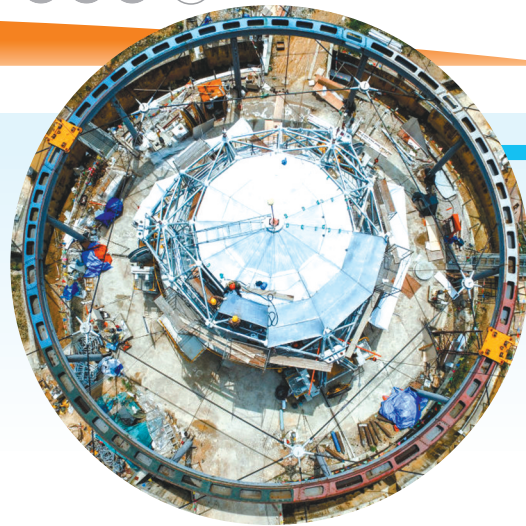
2016年4月10日,工作人员在安装“中国天眼”馈源舱(无人机照片)。
