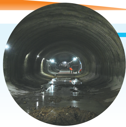
2024年11月24日,青岛胶州湾第二隧道黄岛端陆域段北线完成贯通。
