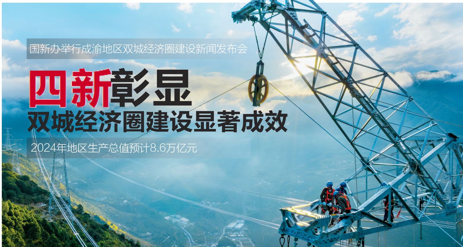
2024年10月15日,在四川省甘孜藏族自治州泸定县,施工人员在川渝1000千伏特高压交流工程进行收紧导线作业。新华社发
