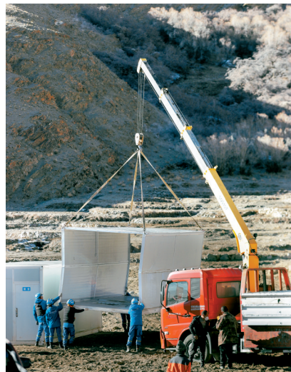
1月8日，在日喀则市定日县长所乡古荣村安置点，救援人员在搭建临时安置板房。
