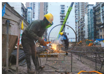
遂宁船山区介福东路106号危旧房改造项目建设现场。
