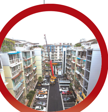
▲内江市东兴区德馨苑小区加装电梯。 兰自涛摄
