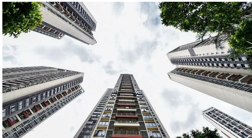
深圳市一处保障性住房项目。图据新华社客户端
