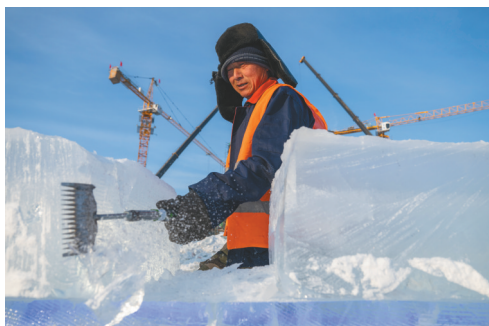
工人正在进行冰建作业。
