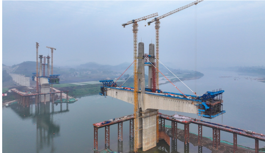
首对斜拉索安装施工现场。
