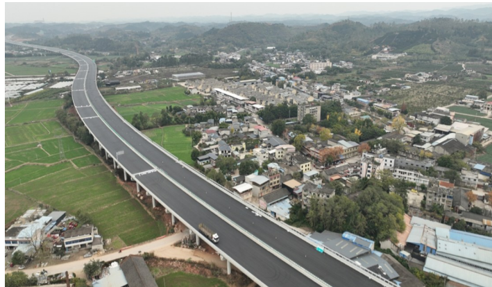
成绵高速扩容项目航拍。蜀道集团川高公司供图
