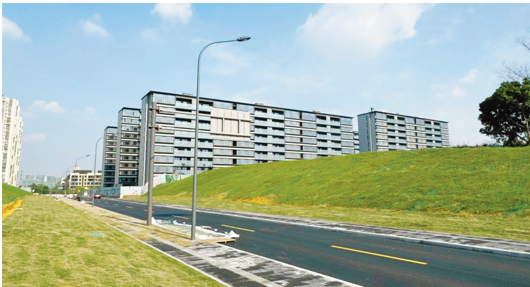
花博路延伸线市政道路项目现场。图据锦江发布
