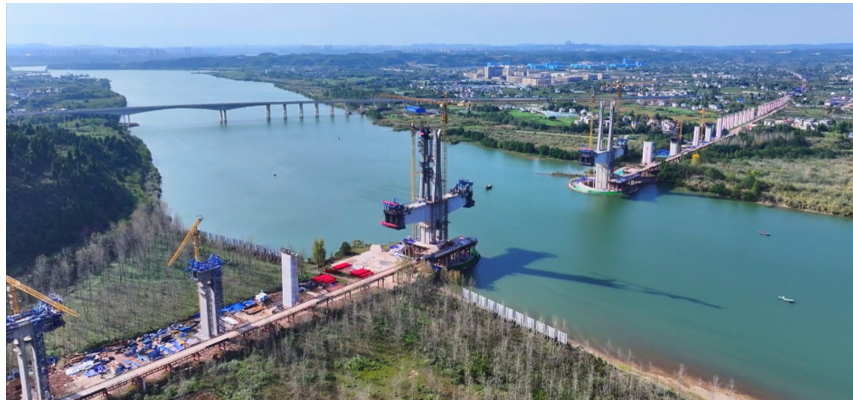
成达万高铁嘉陵江特大桥建设现场。成达万高铁公司供图
