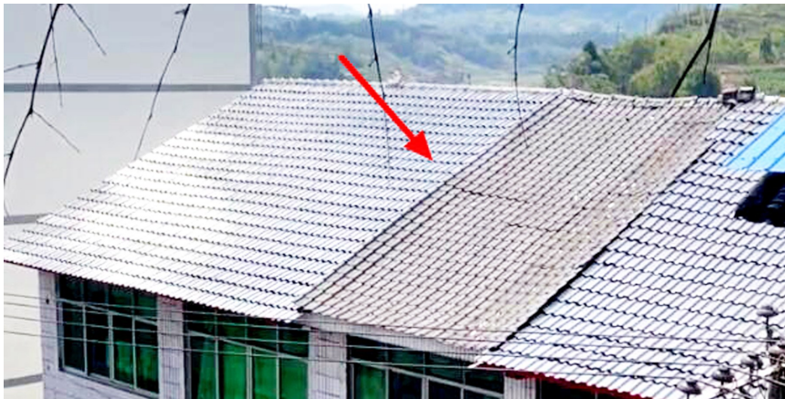
村民在风灾后已维修受损的屋顶。受访者供图
