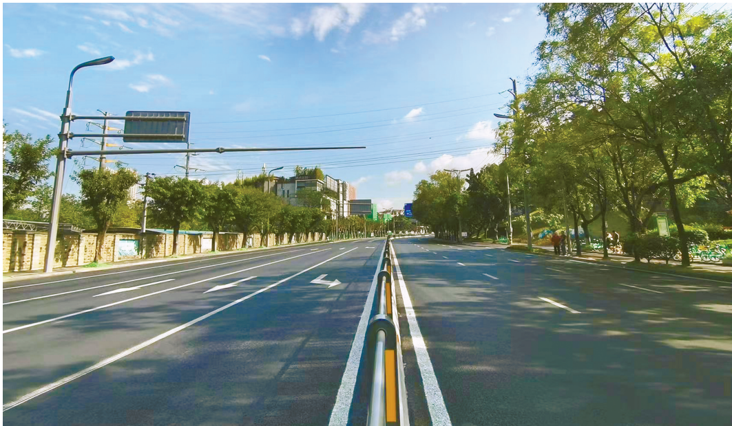
成龙路围挡拆除后的路面。图据成都发布
