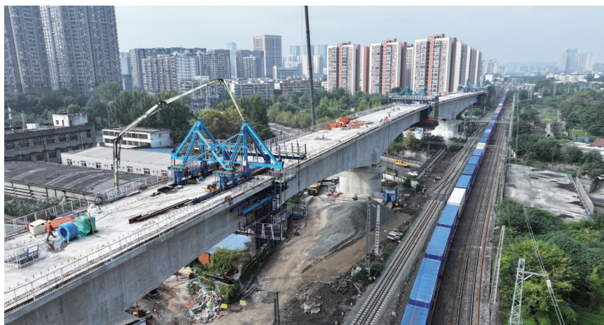
成渝中线高铁动走线跨沙河特大桥连续浇梁合龙现场。
