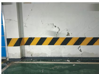
被水浸泡后，地下室墙面开裂。
