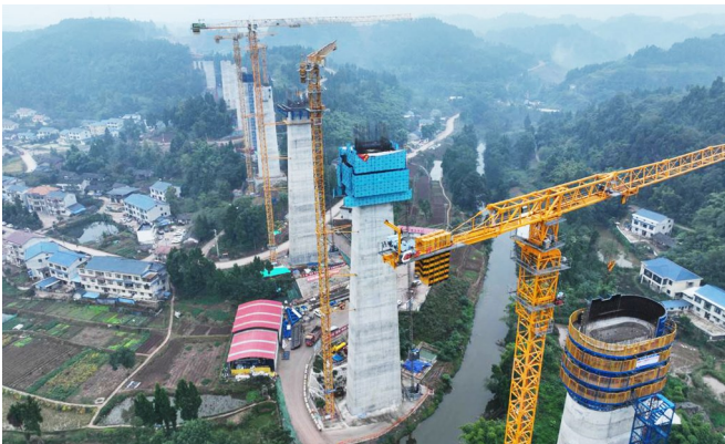
成渝中线高铁田柳湾特大桥21号主墩封顶施工现场。 长江沿岸铁路集团四川有限公司供图
