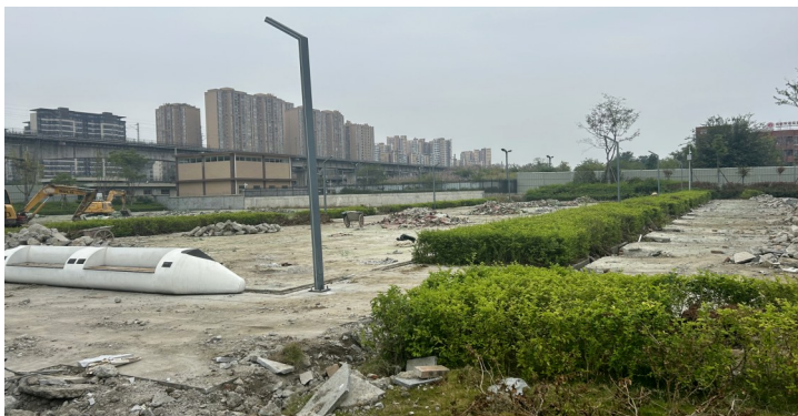
篮球场地面、篮筐已经拆除。 曹菲 摄
