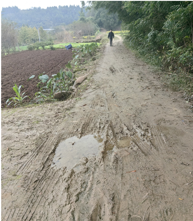
绵阳市三台县西平镇马房楼村“断头路”现状。
