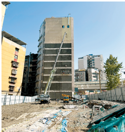
陶家院小区3栋拆除后,旁边的酒店外墙正在施工。
