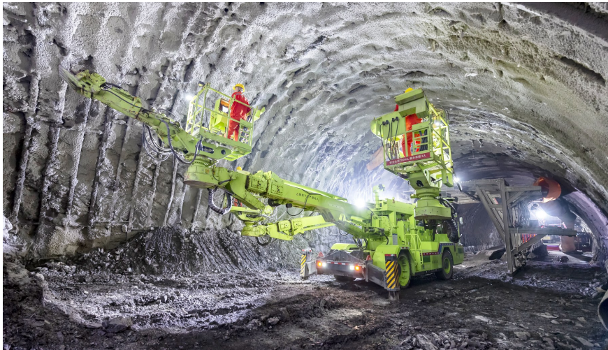
宜攀高速火山隧道成功贯通。蜀道集团供图
