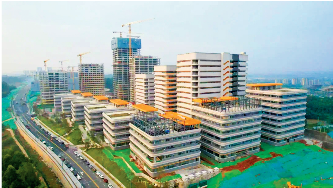
四川天府新区凤栖谷科技创新成果转化基地项目厂房第一批次基本完工。图据成都发布
