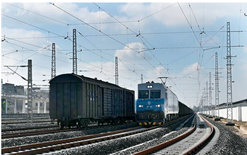
新成昆铁路眉山市站扩能改造工程完成。图据成昆铁路有限责任公司
