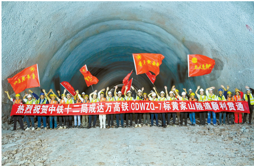
成达万高铁黄家山隧道贯通。
