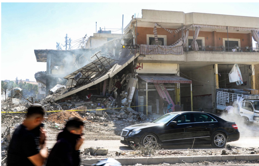
10月15日，在黎巴嫩贝卡谷地，人们掩面走过受损建筑。新华社发
